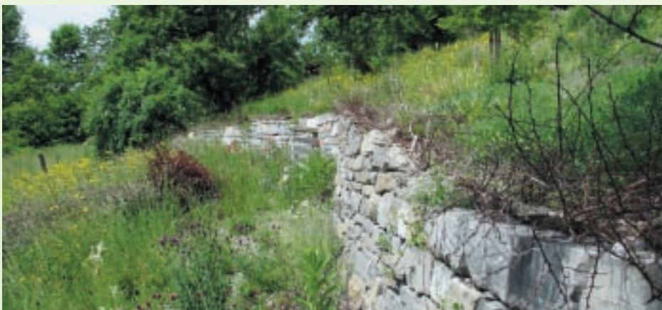
Die Trockenmauern wurden ohne jeglichen Mörtel gebaut und sind ein Refugium für Eidechsen. Die ausgelegten Dornen schützen vor Katzen.
