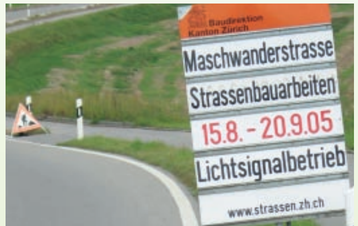
An diesem Strassenstück blieben die meisten Schächte ab ca. 23.8. bis zum Bauende geöffnet.
